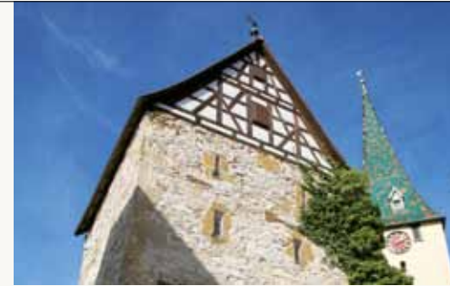
Blockturm am Marktplatz in Heubach
